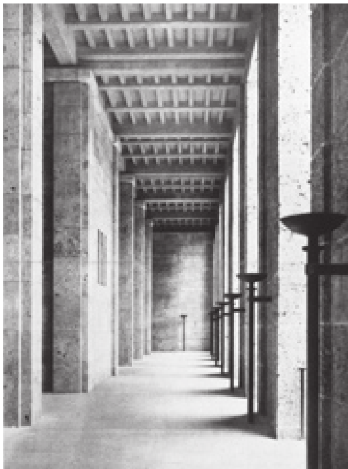
Innenansicht der Langemarck-Halle, Zustand in den dreißiger Jahren
