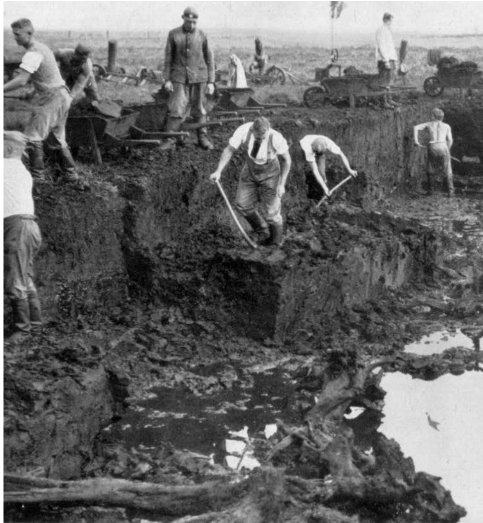
Blut, Boden, Urbarmachung, ökologische Katastrophe – Kultivierungsarbeiten für Siedlerstellen im Emslandmoor 1934
